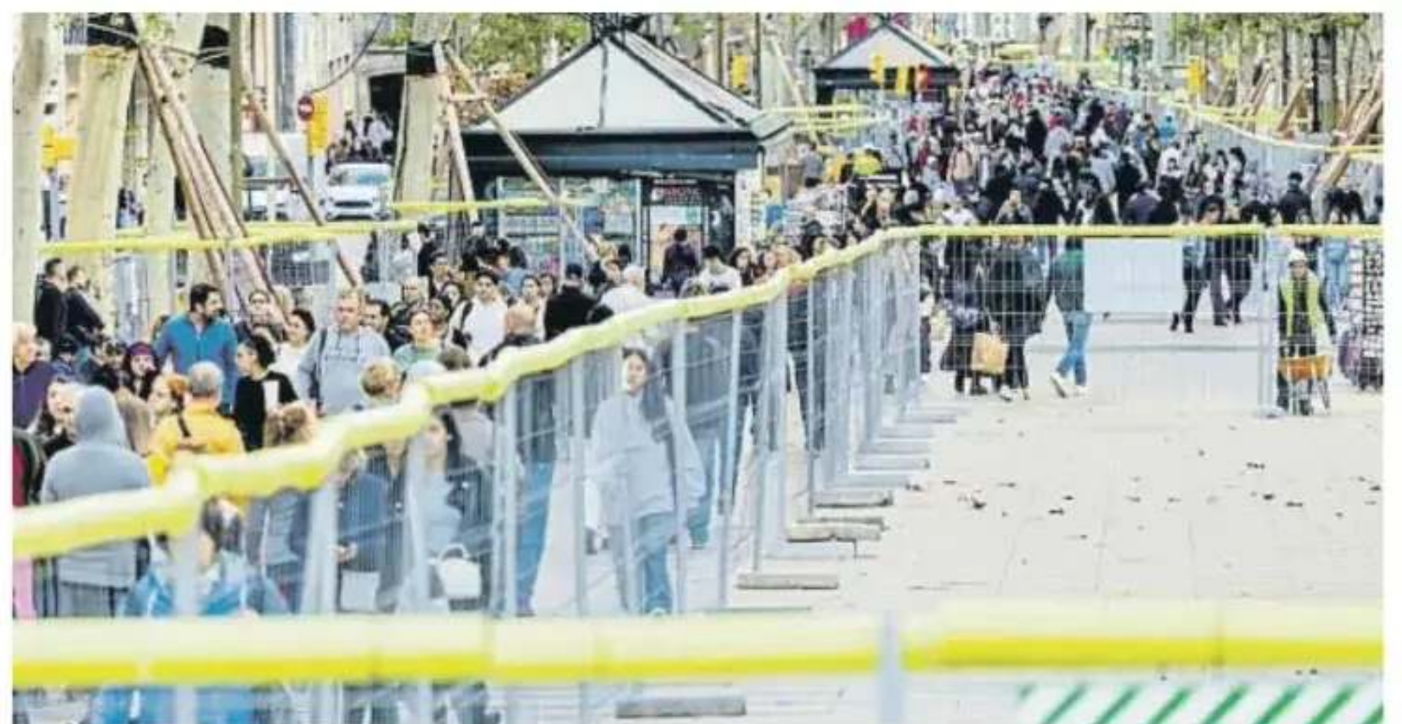
Las obras en el paseo central estrechan la zona de paso de viandantes en la Rambla
